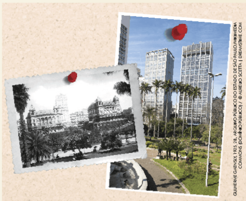
Fig. 7 Vista do Vale do Anhangabaú com os Palacetes Prates e o Edifício Sampaio Moreira. São Paulo, SP.
