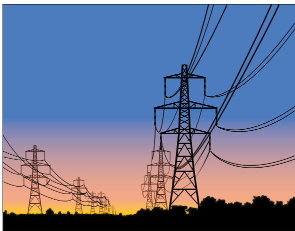
Figura 1. Os cabos de uma linha de transmissão de alta potência se encurvam, entre outros fatores, devido à dilatação térmica.
