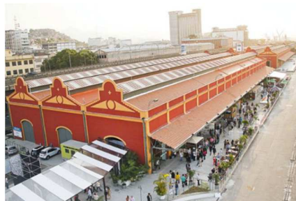
( ) Armazéns no Pier Mauá sediando anualmente a Feira Internacional ArtRio
