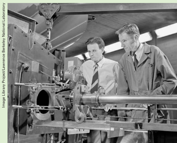
Lattes (à esquerda) e Gardner ajustando o aparato de emulsão para o ciclotron de 184 polegadas. Março de 1948.
