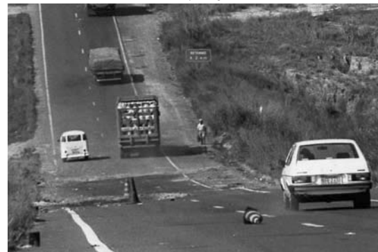
Trecho esburacado e mal sinalizado da rodovia Washington Luís, na região de Campinas, no estado de São Paulo. A rodovia foi privatizada em 1996. Foto de 1983.
