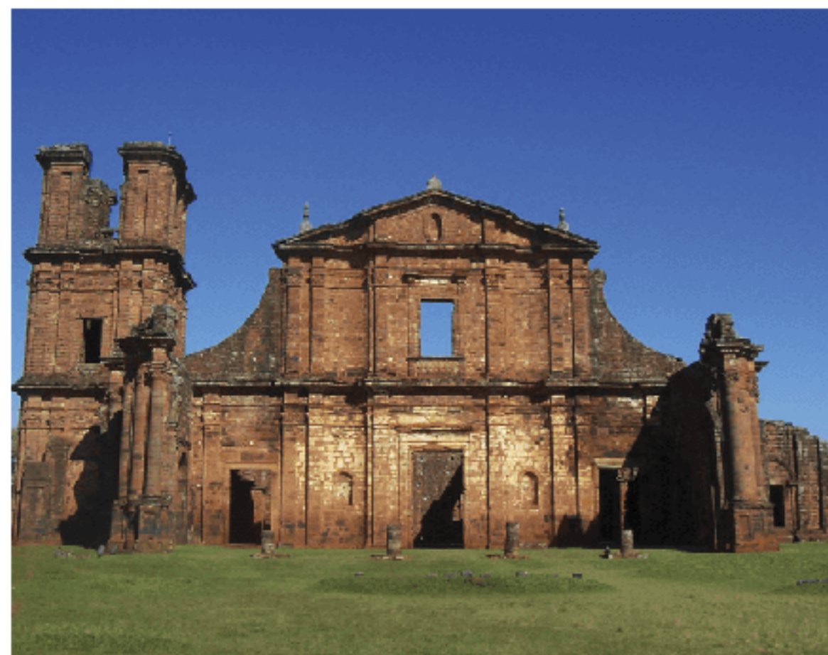
Fig. 19 Ruínas da igreja de São Miguel das Missões. Projeto de João Batista Primoli, 1737-1744. São Miguel Arcanjo, Brasil.
