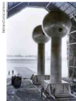
Um dos primeiros modelos de gerador eletrostático construídos por Van de Graaff no MIT (Instituto Tecnológico de Massachusetts). New Bedford, Massachusetts, EUA. Novembro de 1935. New Bedford, Massachusetts, EUA. Novembro de 1935.
