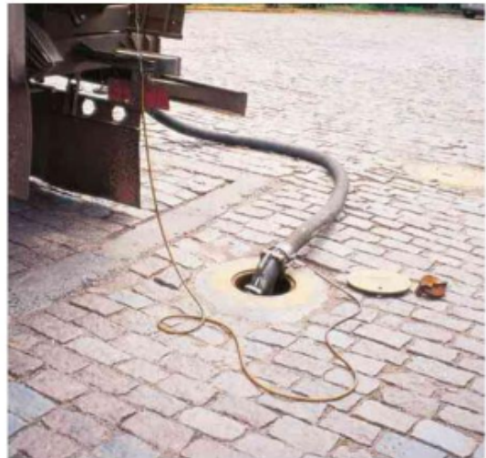
Os caminhões que transportam combustíveis precisam ter o tanque aterrado.
