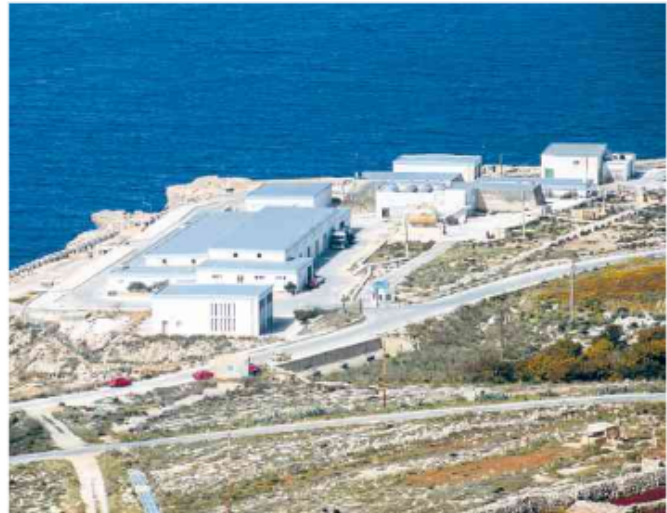
Uma das maiores instalações de dessalinização da água do mar por osmose reversa está localizada na ilha de Malta (Mediterrâneo) e purifica 16 milhões de litros de água por dia.
