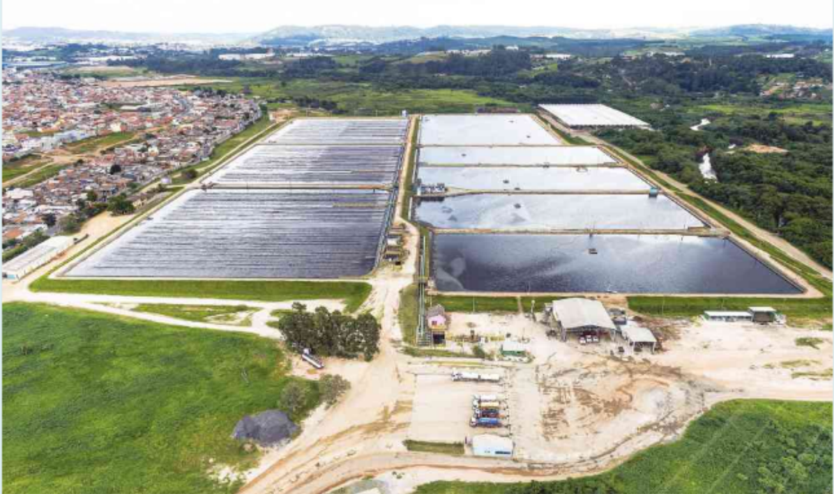
Estação de tratamento de esgoto de Jundiá (SP). 2014.
