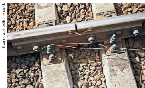
// Espaço entre trilhos em uma estrada de ferro.
