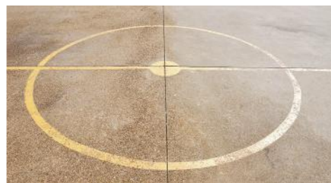
// Piso de uma quadra com o espaço para dilatação.
