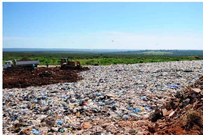
**3.2 – Aterro Controlado:** o lixo é compactado e recebe uma camada de material inerte para evitar contaminação do ar e animais. O chorume fica recirculando por meio de bombas, porém não recebe tratamento adequado trazendo ainda contaminação do lençol freático e solo. O metano oriundo da decomposição da matéria orgânica na ausência do oxigênio é queimado.
