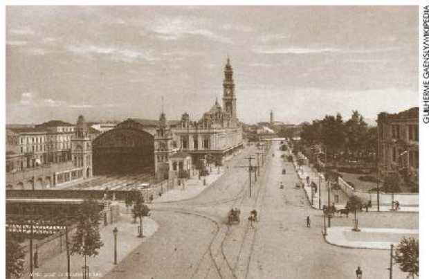
Fig. 10 Estação da Luz, São Paulo. Construída para ser a principal estação da companhia de estradas de ferro britânica São Paulo Railway. Toda sua armação metálica em ferro fundido foi fabricada na Inglaterra e depois enviada ao Brasil.
