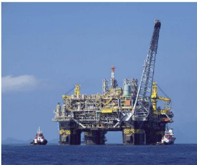
Fig. 8 Petrobras – Plataforma atual da empresa fundada em 1953.
