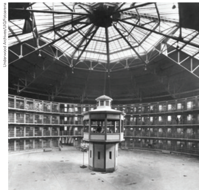
Estrutura do panóptico para presídios, idealizado por Bentham: torre central permite a vigilância constante dos prisioneiros dispostos em celas, em uma estrutura circular.
