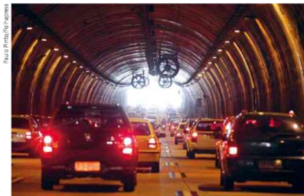
Figura 6.5. Em túneis longos há necessidade de ventiladores para movimentação do ar, reduzindo os efeitos do monóxido de carbono. Na fotografia, túnel na Rodovia dos Imigrantes, em São Paulo, 2012.
