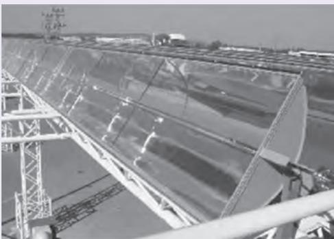
Considerando que a distância entre a borda inferior e a borda superior da superfície refletora tenha 6m de largura e que focaliza no receptor os 800watts/m<sup>2</sup> de radiação provenientes do Sol, e que o calor específico da água é 1cal.g<sup>-1</sup>.°C<sup>-1</sup> = 4.200 J.kg<sup>-1</sup>.°C<sup>-1</sup>, então o comprimento linear do refletor parabólico necessário para elevar a temperatura de 1m<sup>3</sup> (equivalente a 1t) de água de 20°C para 100°C, em uma hora, estará entre
