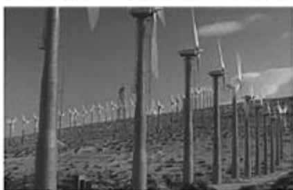
e) Parque eólico na Califórnia
