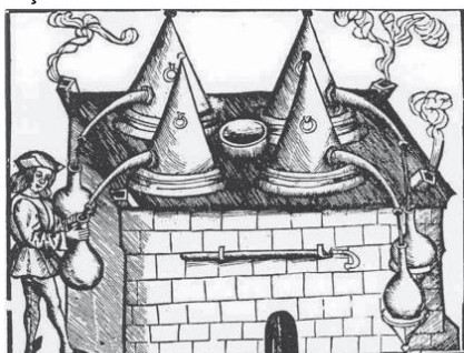
Imagem representando o processo de destilação, extraída da obra Liber de arte distillandi (1512), de Hieronymus Brunschwig.
