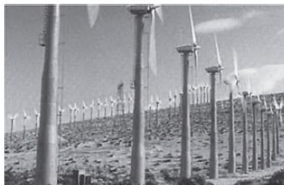
E) Parque eólico na Califórnia
