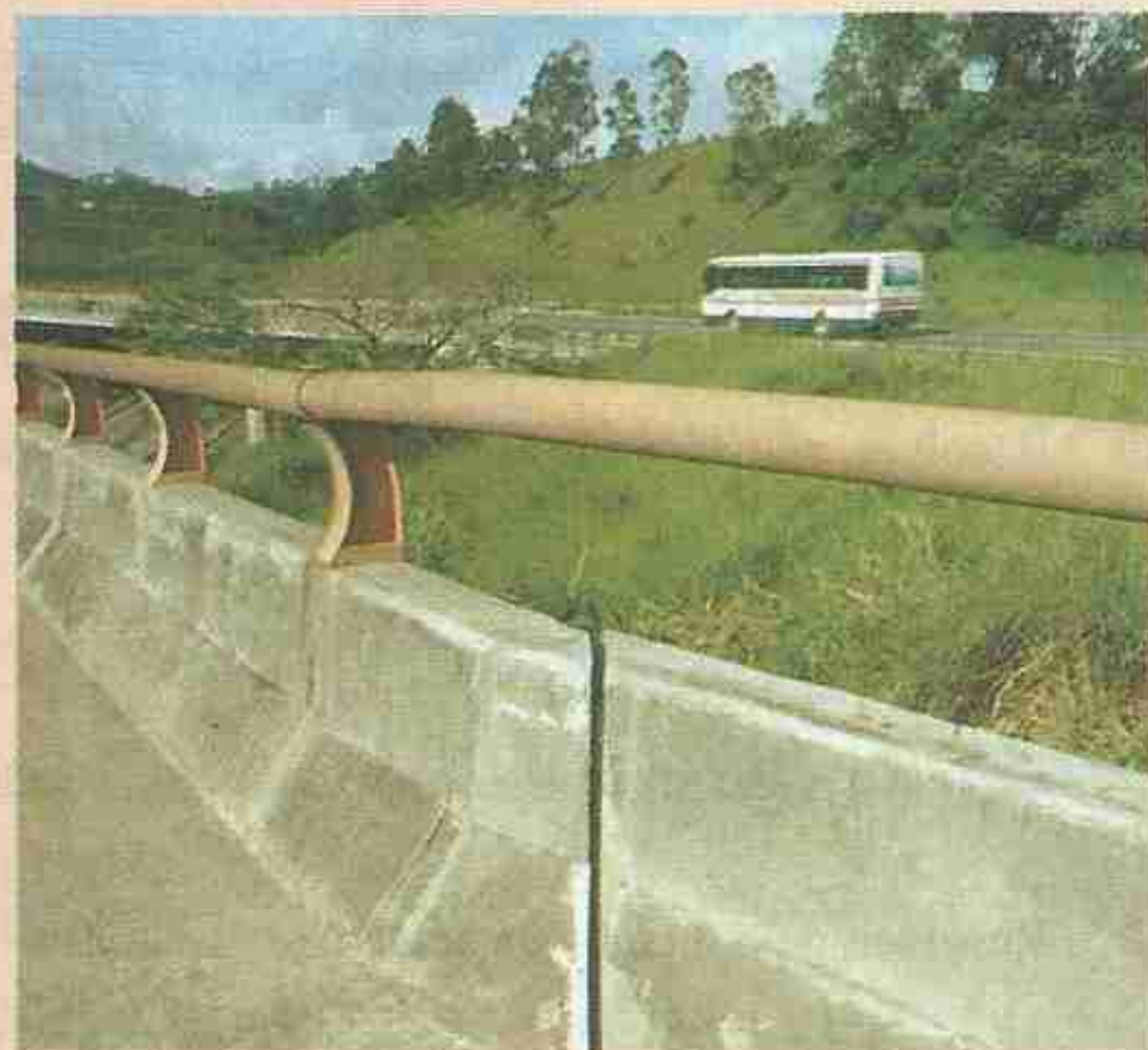
Os vãos que se observam entre as peças de concreto que compõem uma ponte ou viaduto são chamados de juntas de dilatação . Suas dimensões são calculadas de modo a evitar danos à estrutura causados por variações de temperatura.
