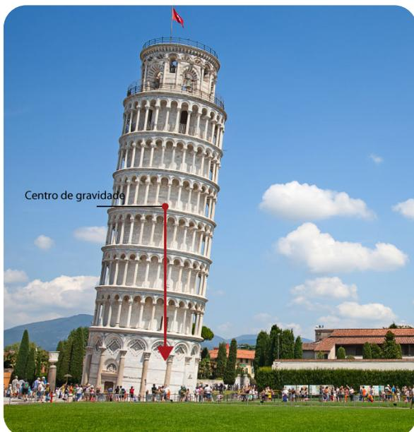
A localização do centro de gravidade é importante para a estabilidade de um objeto. Se traçarmos uma linha reta para baixo, a partir do centro de gravidade de um objeto com uma forma geométrica qualquer, e ela incidir num ponto do interior da base do objeto, então o objeto está em equilíbrio estável; ele se equilibra. Se a linha incidir num ponto exterior à base do objeto, o equilíbrio é instável.
