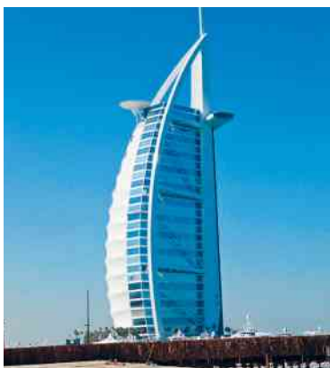
Hotel Burj Al Arab em Dubai, Emirados Árabes, 2015.
