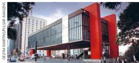
MASP, Museu de Arte de São Paulo. Obra da arquiteta Lina Bo Bardi, construída em 1968.
