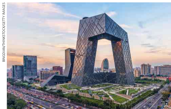
Essa surpreendente construção (sede da Televisão Central da China) também lembra um poliedro não convexo. Pequim, China, 2015.
