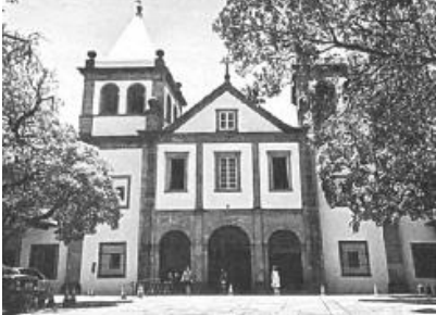
Mosteiro de São Bento (RJ)
