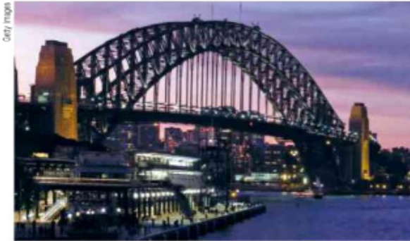
Ponte Harbour, Sidney (Austrália). Julho de 2015. Conhecimentos de Estática foram necessários para garantir as condições de equilíbrio dessa ponte.
