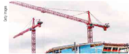
Grua usada em obra no Aeroporto Internacional de Denver, Colorado (EUA). Setembro de 2014.
