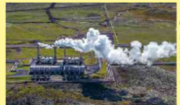
Usina geotérmica de Nesjavellir, Islândia. Julho de 2013.
