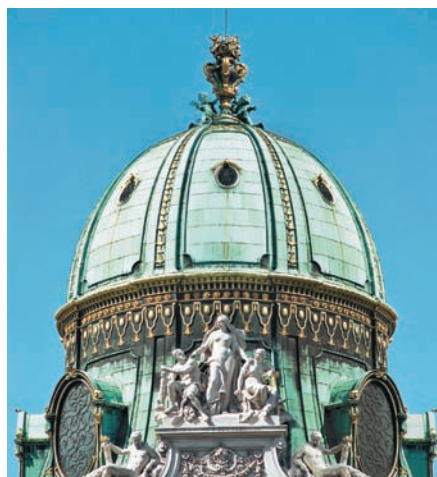
Cúpula de cobre recoberta com azinhavre. (Palácio de Hofburg, Viena, Áustria, 2000.)
