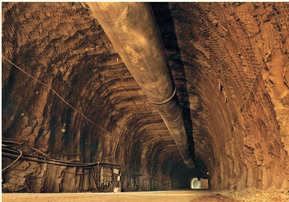
Vista de um dos túneis da antiga mina de ferro de Konrad, que está sendo adaptada para armazenar rejeito radioativo em 2013. [Salzgitter, Alemanha, 2008.]
