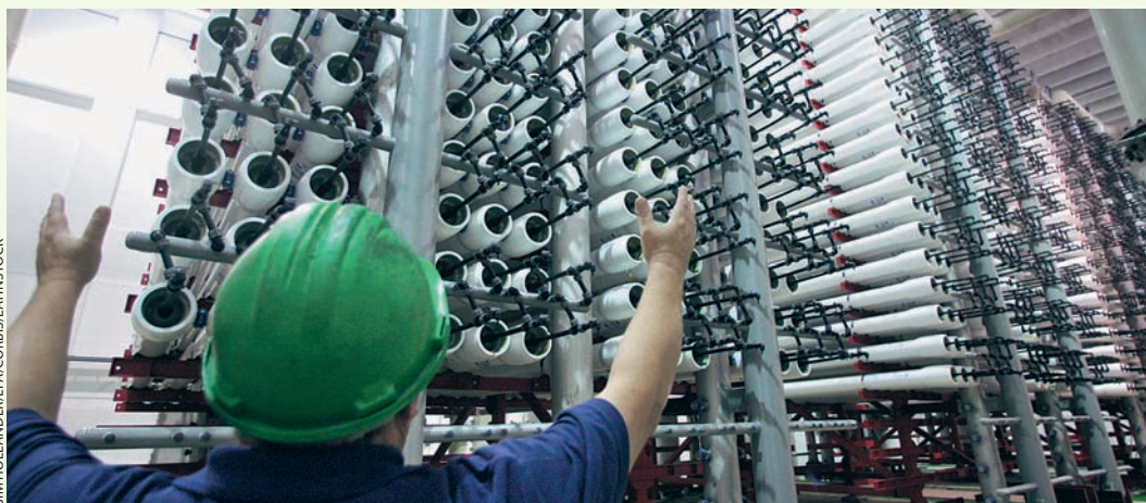
Unidade de dessalinização de água por osmose reversa para o abastecimento da rede pública em Tel Aviv, Israel, 2007.
