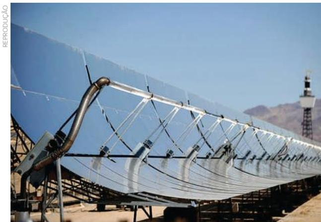
Fig. 2 Espelhos parabólicos em usinas solares
