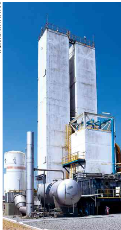
Torre industrial de destilação fracionada do ar atmosférico em Mauá (SP).
