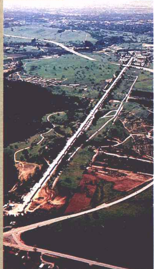
Fig.5-28: Esta edificação, na Universidade de Stanford (E.U.A.), abriga um acelerador linear, com cerca de 4 km de comprimento, que é capaz de acelerar elétrons até atingirem 99,9% da velocidade da luz.
