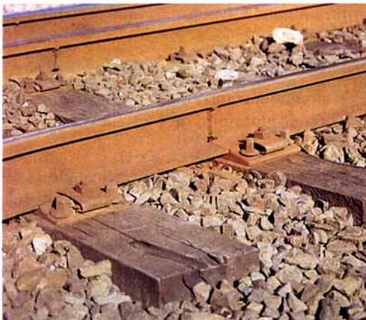
Figura I: Procure explicar por que os trilhos de uma estrada de ferro são apoiados sobre dormentes, como vemos nesta fotografia.
