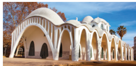
Edifício modernista Masia Freixa, com estrutura formada por arcos e abóbadas. A construção está localizada no Parque de Sant Jordi, em Terrassa, Espanha. Foto de 2017.
