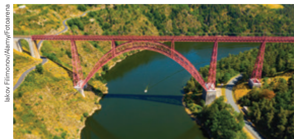
Vista panorâmica da estrutura em arco parabólico da ponte ferroviária Viaduc de Garabit, que atravessa o rio Truyere, em Auvergne, França. Foto de 2020.
