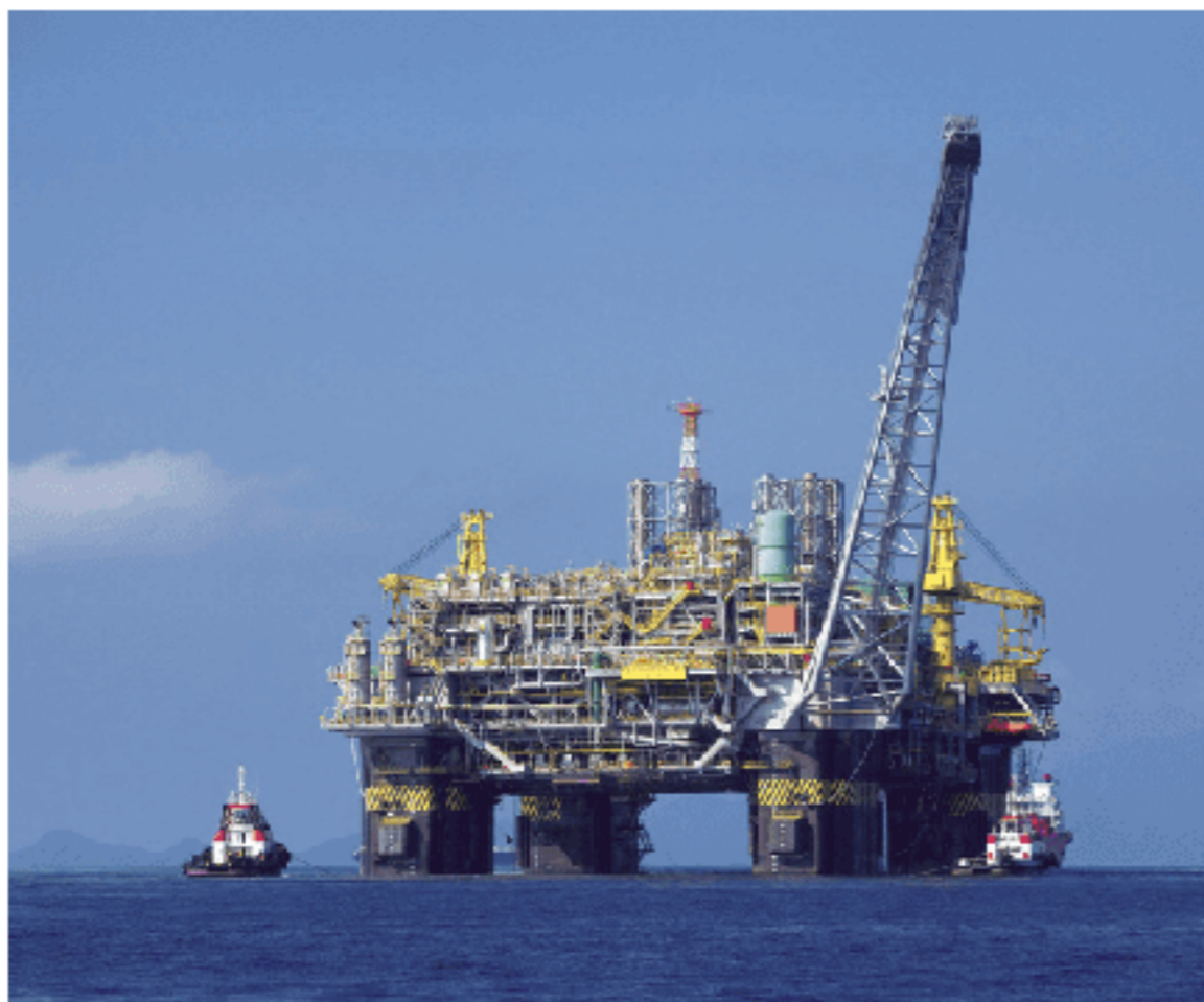
Fig. 8 Petrobras – Plataforma atual da empresa fundada em 1953.
