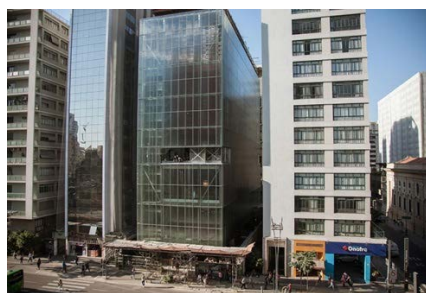
IMS Paulista em construção.
