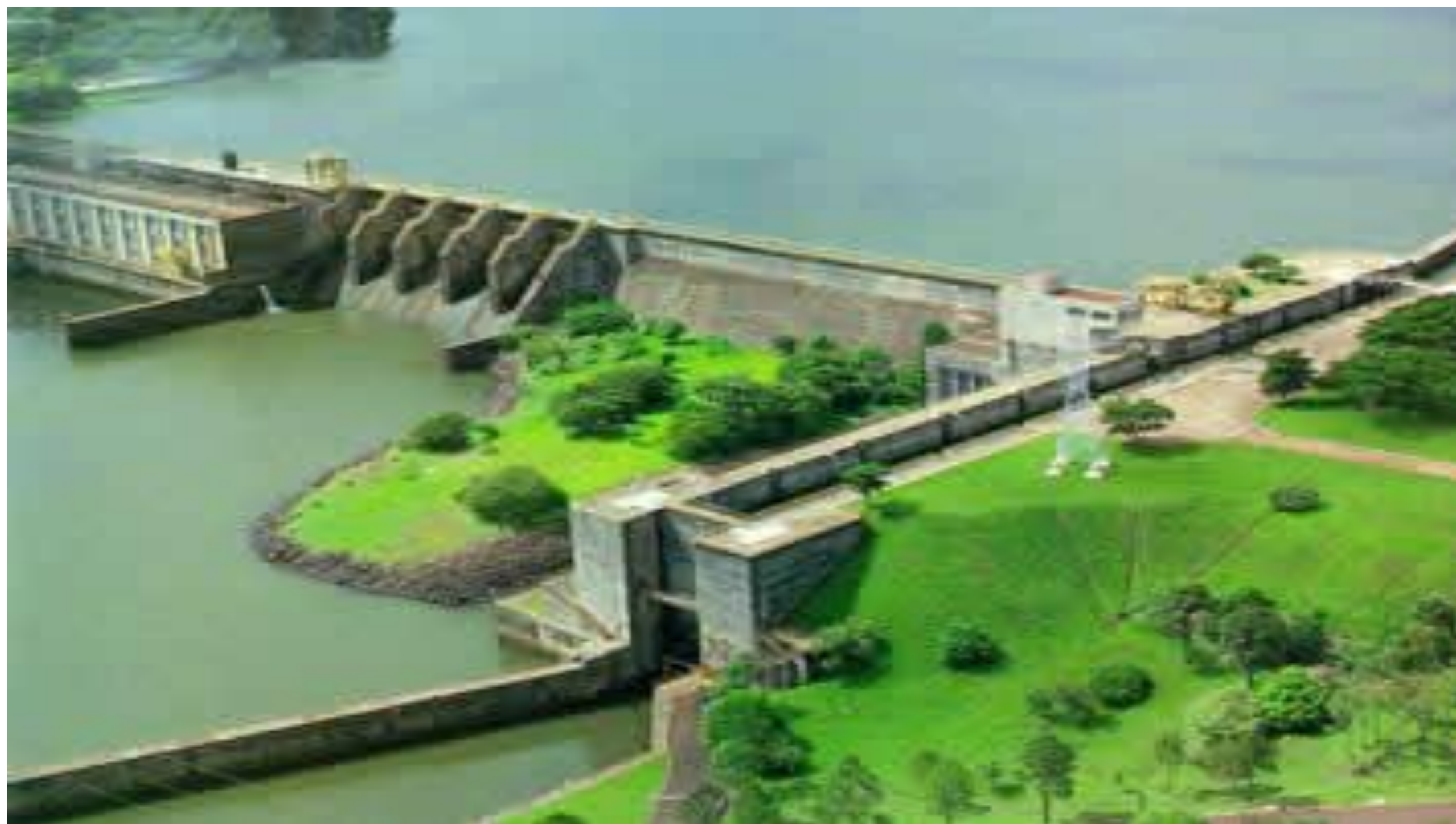
Foto da Eclusa de Bariri no Rio Tietê
