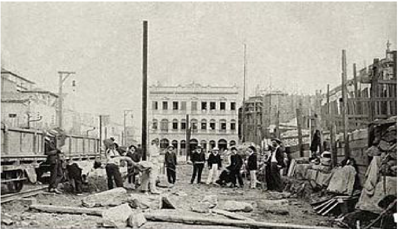
Demolições para a construção da avenida Central, 1904-1905 João Martins Torres – Acervo Instituto Moreira Salles
