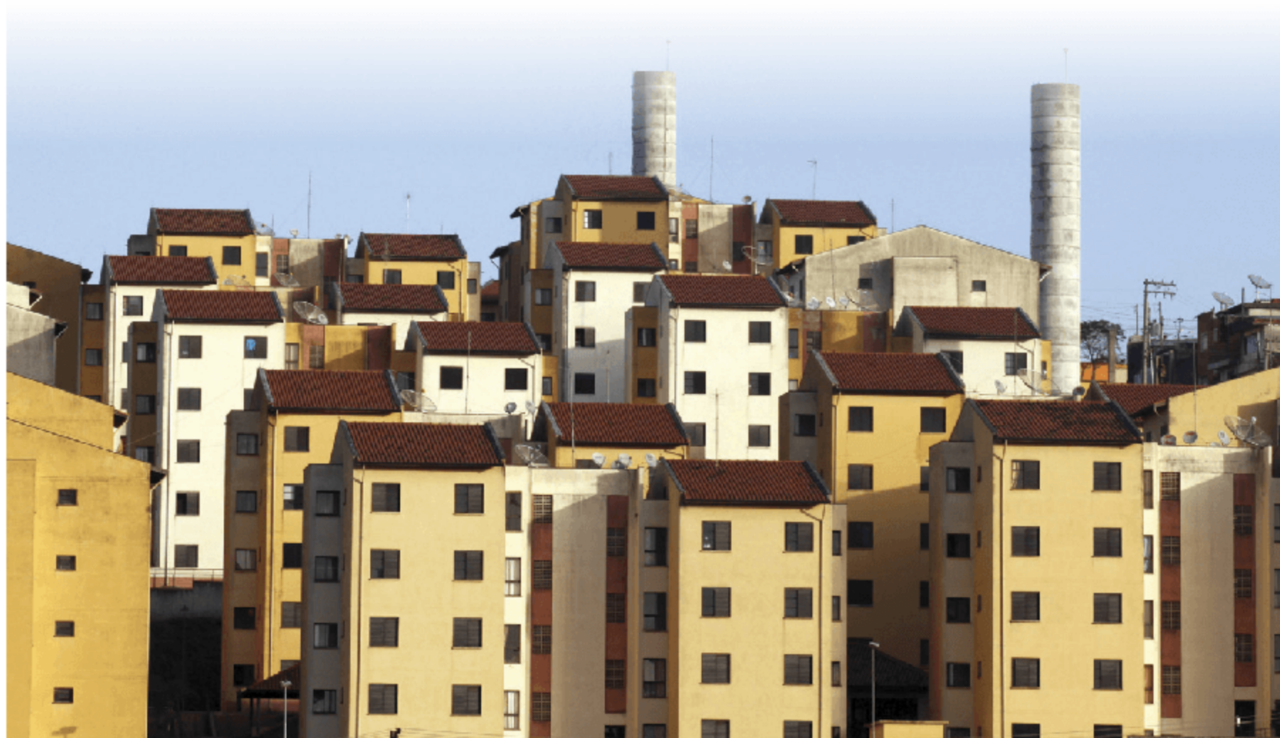
O acesso à moradia, bem como as melhores condições habitacionais, é um dos indicadores levados em conta pelo IDF, do Governo Federal.
