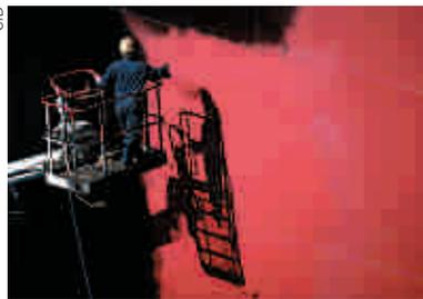
A ferrugem se forma na reação entre ferro, água e oxigênio. Quando o ferro é adequadamente revestido com tinta, impede-se o seu contato com água e oxigênio, isto é, reduz-se a zero a superfície de contato dele com os outros reagentes. É uma forma de prevenção da ferrugem.
