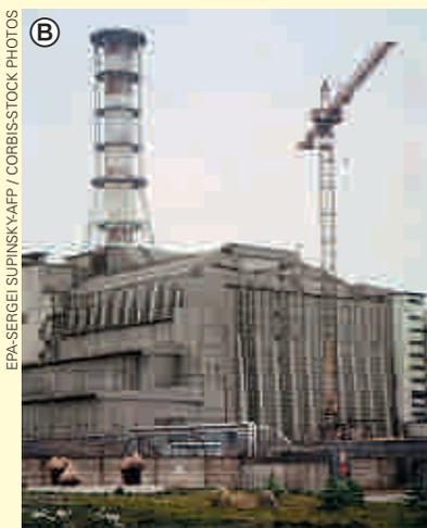
(B) Imenso túmulo, feito com 300 mil toneladas de concreto, visando isolar os resíduos que ainda permanecerão sofrendo decaimento radioativo por décadas.
