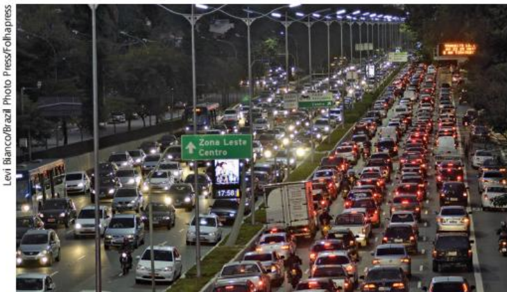
Figura 2. Em uma cidade, um sistema viário, constituído por ruas e avenidas, permite o deslocamento de pessoas e de produtos diversos. O transporte público escasso e a malha viária insuficiente para as demandas geradas pela população acarretam perda de tempo e tornam lento o deslocamento pela cidade. Nas metrópoles, as áreas mais poluídas são as grandes vias expressas (em baixadas ou vales de rios) e as zonas críticas de congestionamento. (Na fotografia, avenida 23 de Maio, em São Paulo, 2014.)
