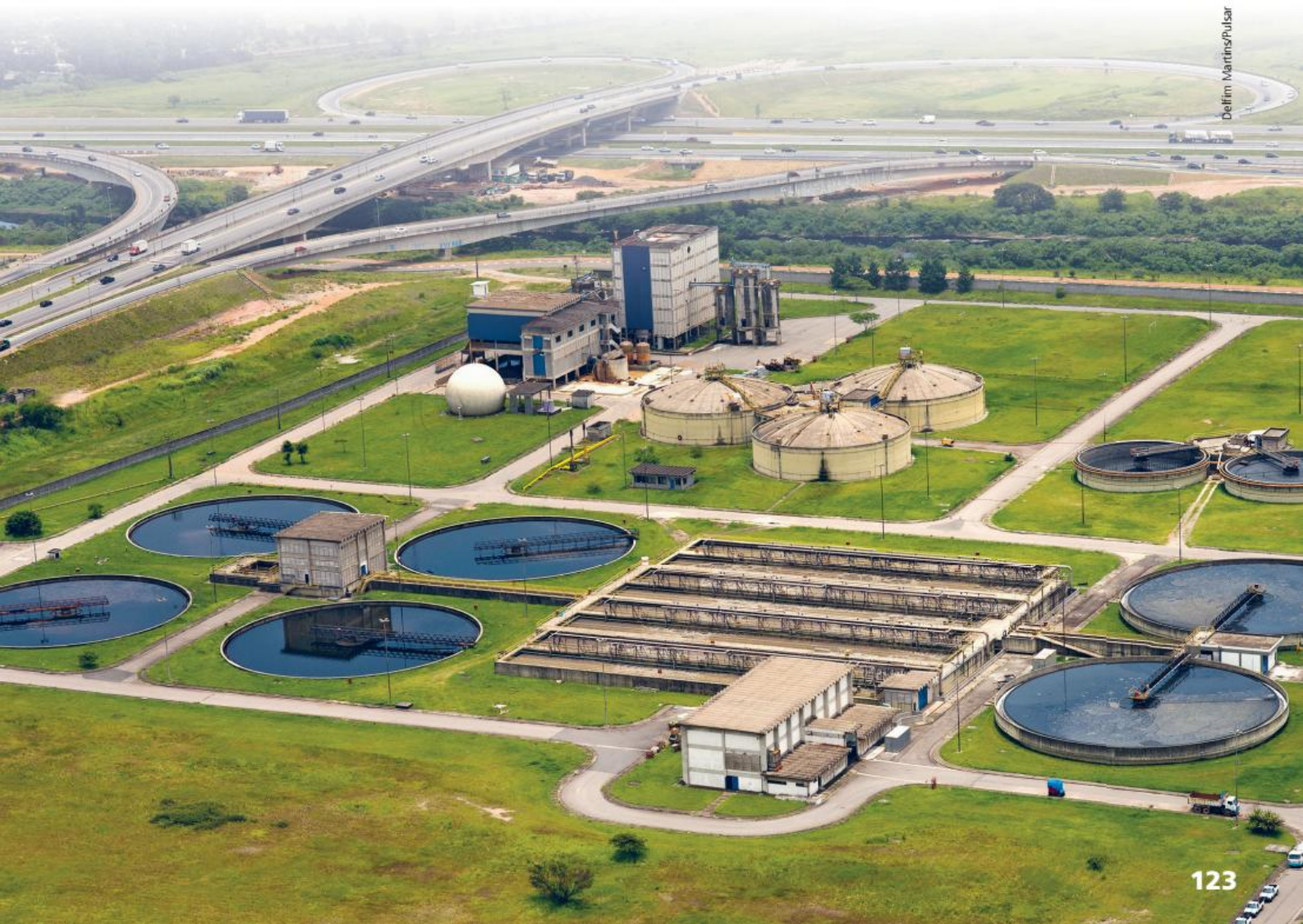
Figura 21. Estação de tratamento de esgoto em São Paulo (SP), 2013.
