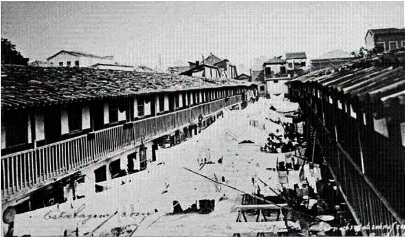
Cortiço na rua Visconde do Rio Branco (RJ)
