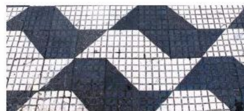
Ladrilhamento das calçadas da cidade de São Paulo
