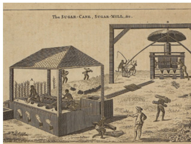
Engenho de açúcar. Ilustração feita para o livro Novo e Completo Dicionário de Artes e Ciências , publicado na Inglaterra em 1763.
