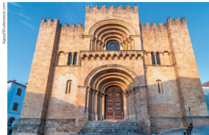
A Igreja da Sé, em Coimbra, Portugal, é uma construção do século XII com estilo arquitetônico românico.
