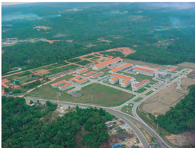
O conjunto de prédios do SIVAM em Manaus – Julho de 2002.
