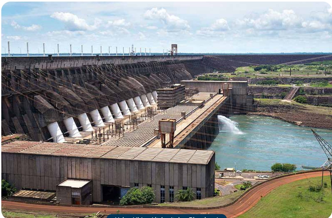
Usina Hidroelétrica Itaipu Binacional
