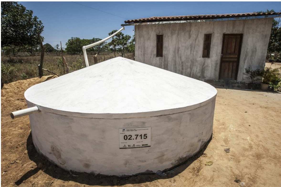
Figura 20 – Cisterna Fonte: CMA-CBIC
