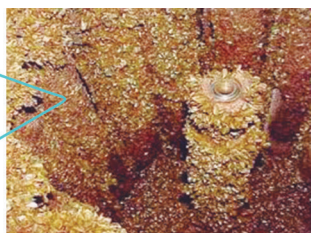
Crescimento de mexilhões no filtro autolimpante de uma usina.
