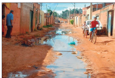
Rua sem rede de esgoto.
