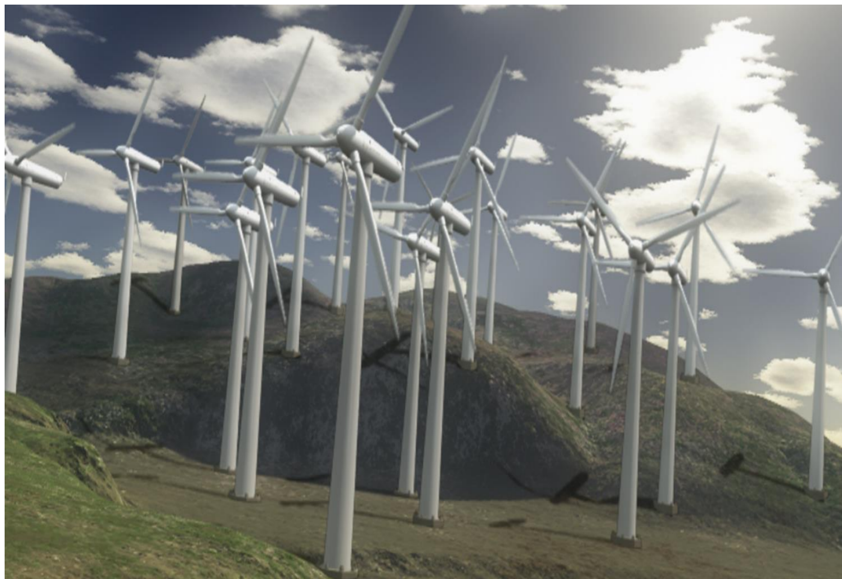
Central de Geração Eólica. Fonte: Petrobrás
