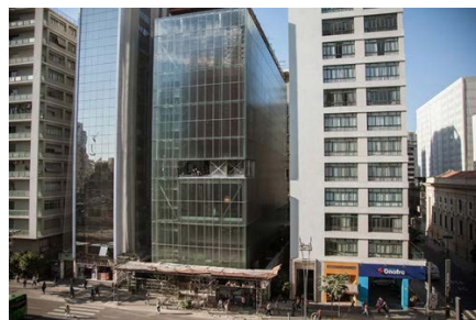
IMS Paulista em construção.
