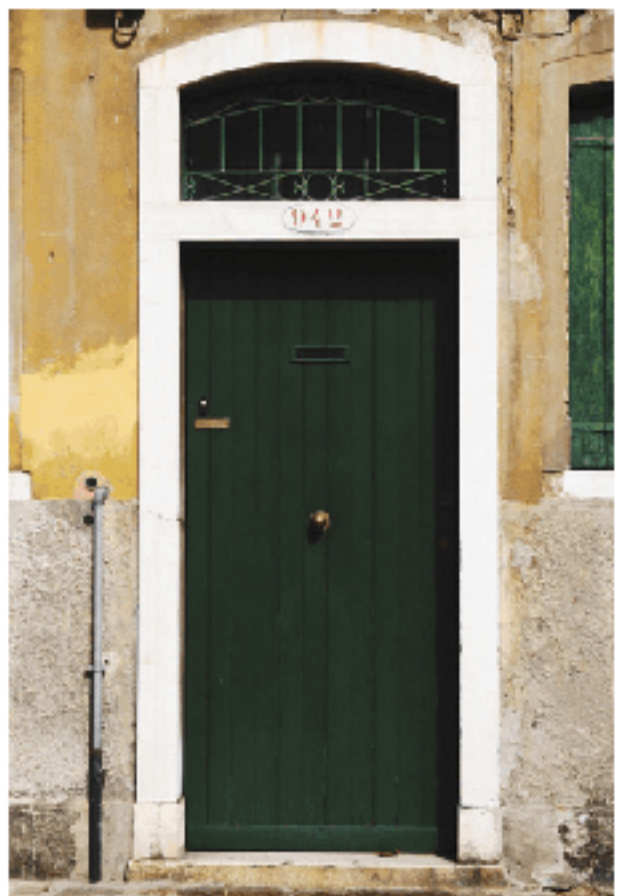
Fig. 21 Será que é eficiente posicionar a maçaneta no meio de uma porta? Nesse caso, para abri-la é necessária a aplicação de uma força maior do que se a maçaneta fosse posicionada na extremidade oposta às dobradiças.
