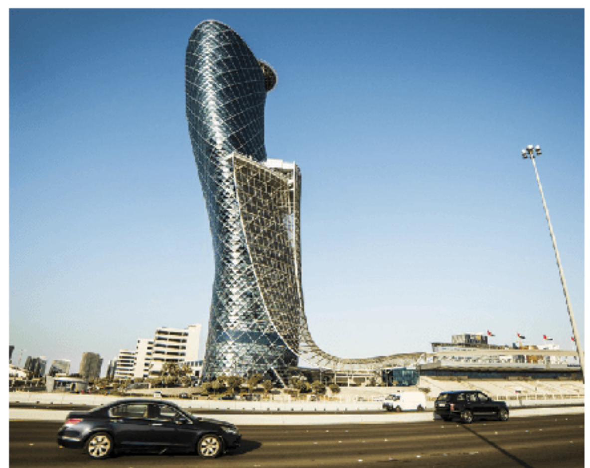
Fig. 31 O edifício Capital Gate, em Abu Dhabi, tem uma inclinação de 18°. É o edifício mais inclinado do mundo.
