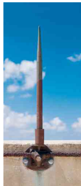
Figura 5.10 O funcionamento de um para-raios, assim como a atração que objetos altos oferecem a raios, são explicados pelo poder das pontas em condutores.
