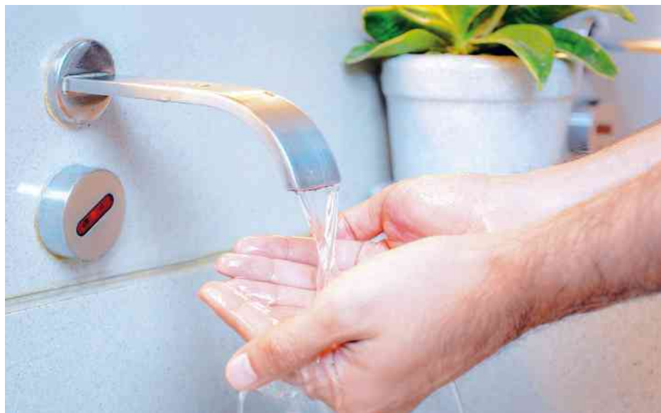
Figura 8.16 Pessoa utilizando uma torneira automática. Na base da torneira podemos visualizar o dispositivo que emite radiação infravermelha.
