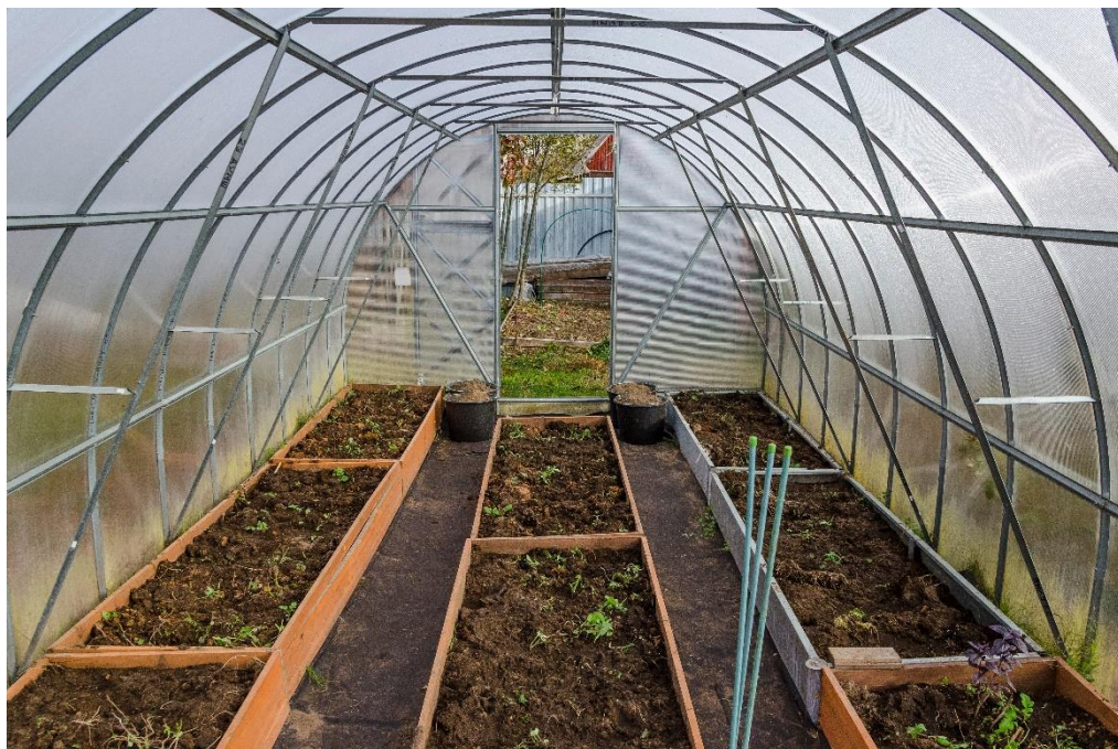
Figura 36: Telhado de Policarbonato
