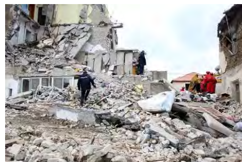
Imagem 13 - Área destruída após um terremoto na Albânia
