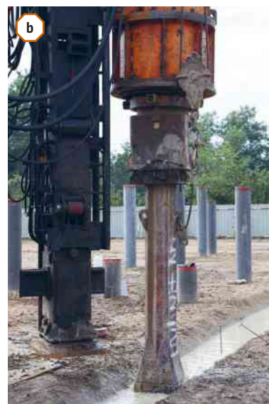
Figura 7.28 Durante a queda do bate-estaca, a energia potencial transforma-se em energia cinética.
