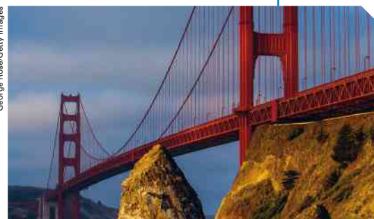
Ponte Golden Gate, em São Francisco, Califórnia (EUA), 2015. Toda a pista rolante é dependurada em cabos de aço, com um cabo principal formando um arco invertido.
