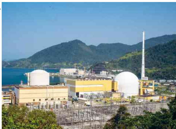
Figura 7.17 Vista de cima das usinas que compõem a Central Nuclear Almirante Álvaro Alberto (CNAAA), em 2015. Em operação comercial desde 1985, Angra I, em Angra dos Reis (RJ), foi a primeira usina nuclear construída no Brasil.
