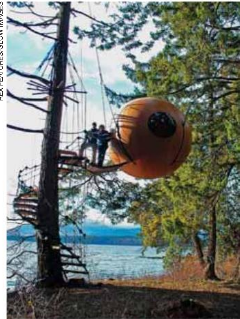
Hotel em Vancouver, Canadá, 2013. Para que os hóspedes se sintam integrados à natureza, os quartos do hotel têm a forma de esferas presas às árvores por meio de cabos e de suportes.
