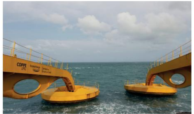
Fig. 42 Flutuadores e braços mecânicos da usina ondomotriz de Pecém-CE.
