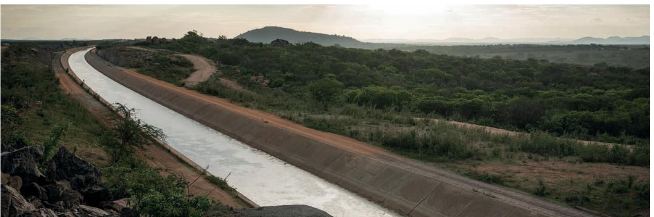
Fig. 7 Observamos, na imagem, um dos canais de transposição do Rio São Francisco. Pesquisadores e ambientalistas contrários ao projeto alertam para a perda de água por evaporação, potencializada pelo fato de a construção estar em áreas de clima quente e pouco úmido.
